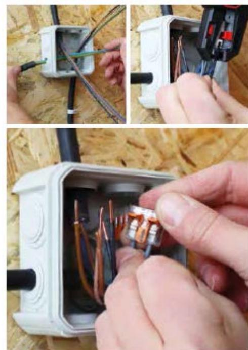
Универсальная коробка CG нового поколения позволяет легко и удобно соединять кабели всего в несколько шагов. Семь гидроизолированных вводов, находящихся по бокам коробки, обеспечивают гибкое расположение кабельных вводов. Поставляемые соединители WAGO COMPACT делают монтаж проводов в корпусах различного размера максимально удобным.
